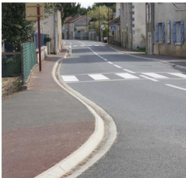
Traverse sécurisée du bourg de Quinsac (signalétique au sol et vertical, trottoirs)
