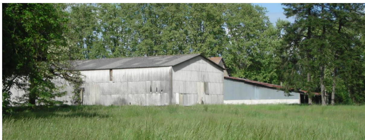
Figure 14 Est du site depuis la voie d'accès hôpital existante avec hangar et construction existante
