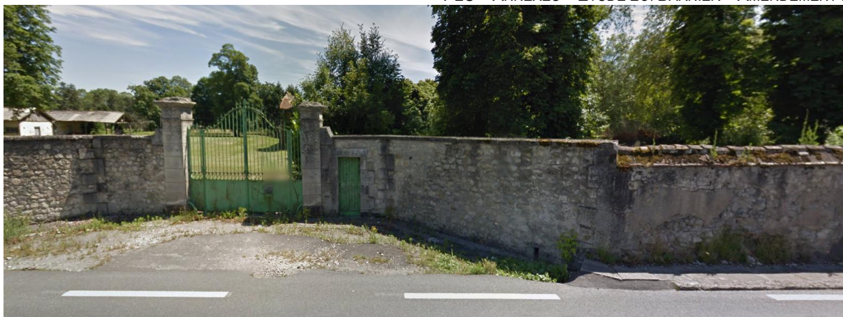
Figure 28 Nouvel accès envisagé hypothèse 1 : le portail secondaire en face des terrains de sport
