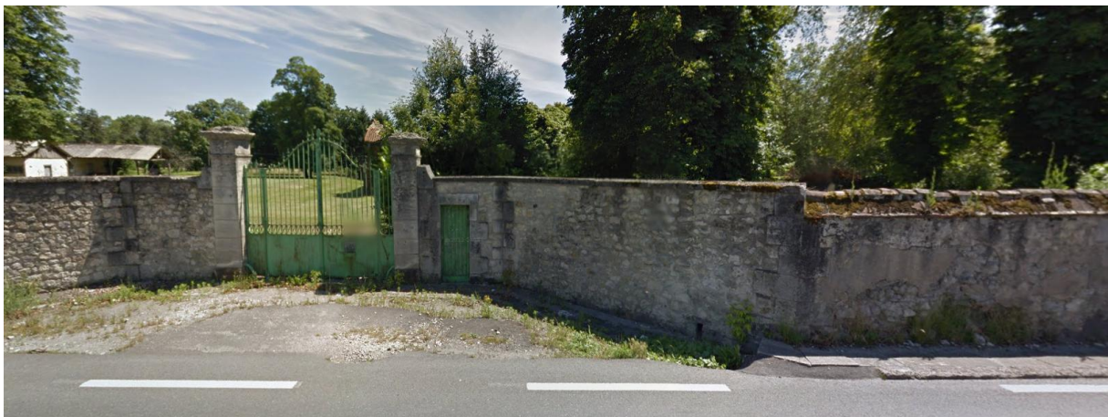
Figure 16 Le portail secondaire en face des terrains de sport
