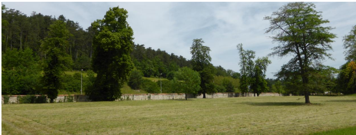
Figure 12 Entrée Ouest, terrains derrière le mur
