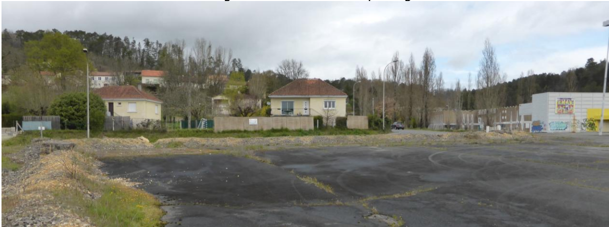
Figure 5 Vue depuis le giratoire Sud-Ouest
