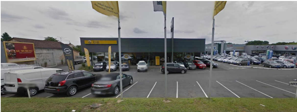
Figure 4 Façade UB avec extension à l'arrière
