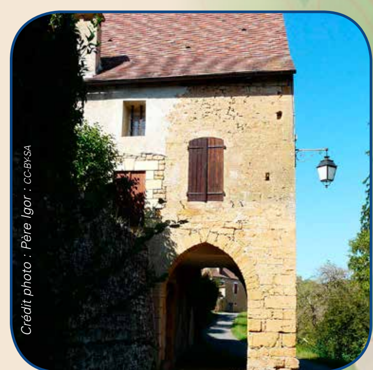
Corps de bâtiment sud de la maison La Recette
